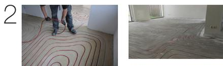
熱水系統 - 乾式系統
